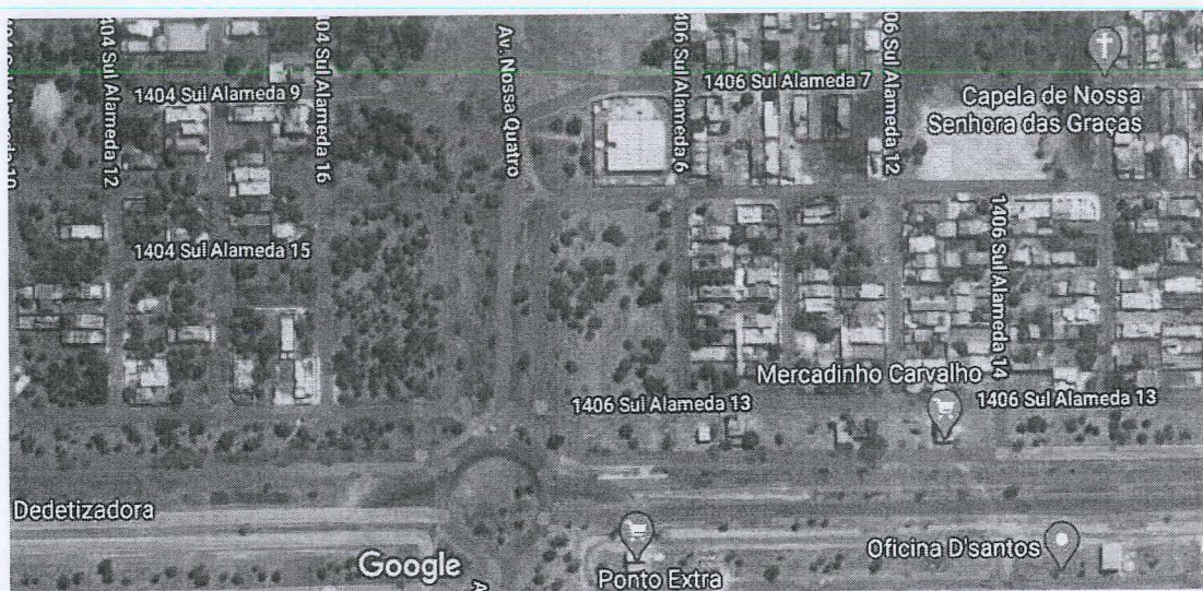
Figura 01- Imagem de Satélite da Avenida NS-04 (entre a entrada da ARSE 142 e Av. LO-33, incluindo alça) à pavimentar.
